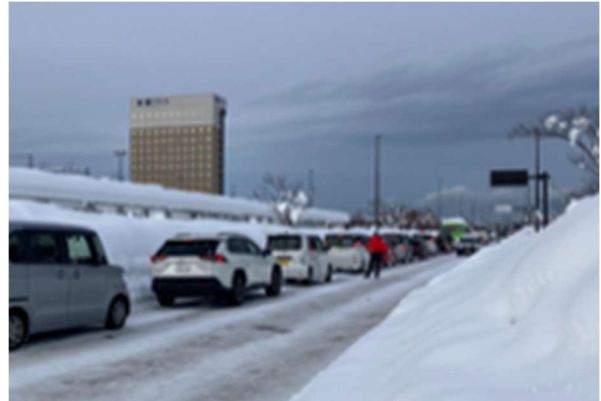
図5 新青森駅付近での道路状況。幅員が狭く、つるつるの路面となり渋滞が発生している。 2025/1/5 14:47撮影。
