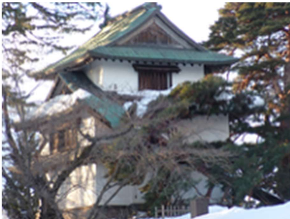
図6 針葉樹の倒木による築400年の弘前城二の丸末申櫓の損壊。 2025/1/13 16:05撮影。
