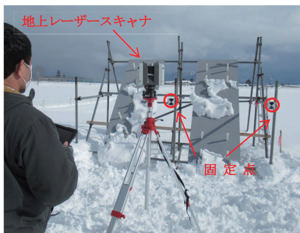
図 3 地上レーザースキャナによる計測状況
