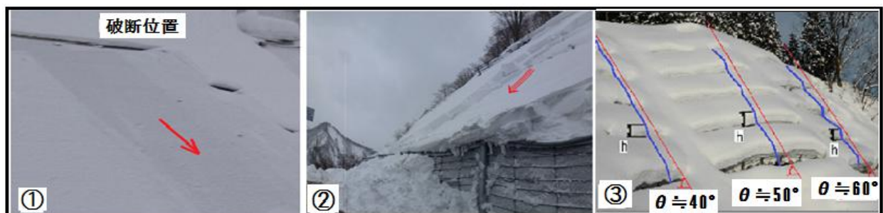
図8 ①上部斜面からの崩落 ②下部斜面からの崩落 ③階段工のような雪面(安定)
