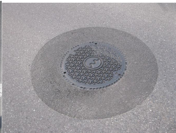
図 12 マンホール回りの補修
