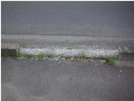
図1 歩車道ブロックのスケーリング現象
