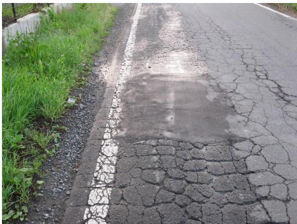
図 9 舗装の剥がれ部補修
