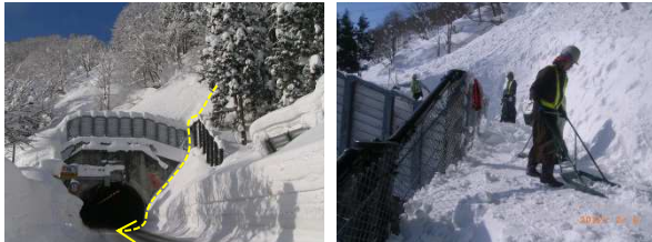
写真1 芝原TN坑口全景 写真2 除雪作業状況
