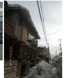
図 5 甲府市屋根雪崩落の危険性
