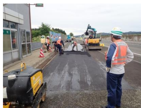
図2 アスファルト舗装施工の様子（2024年8月29日）
