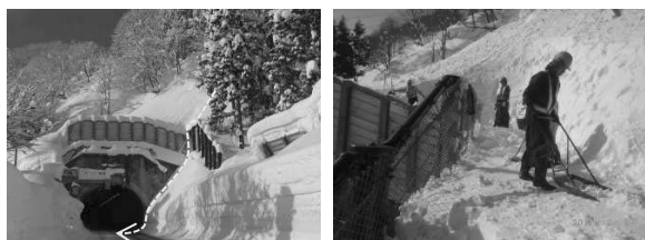
写真1 芝原TN坑口全景
