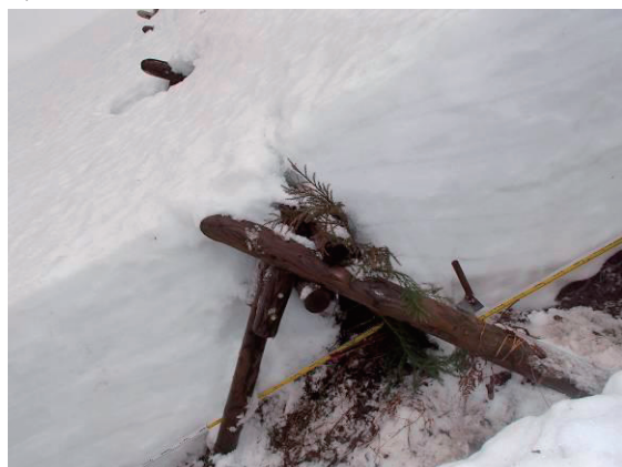
写真3 グライド防止三角枠工での積雪断面
