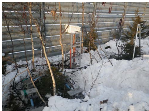
図2 パイプひずみゲージ等の設置状況
