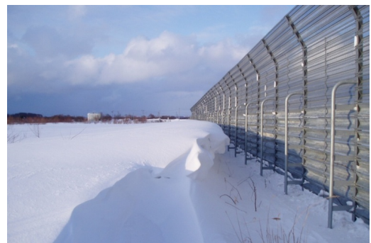
図-7 吹き止め式防雪柵
