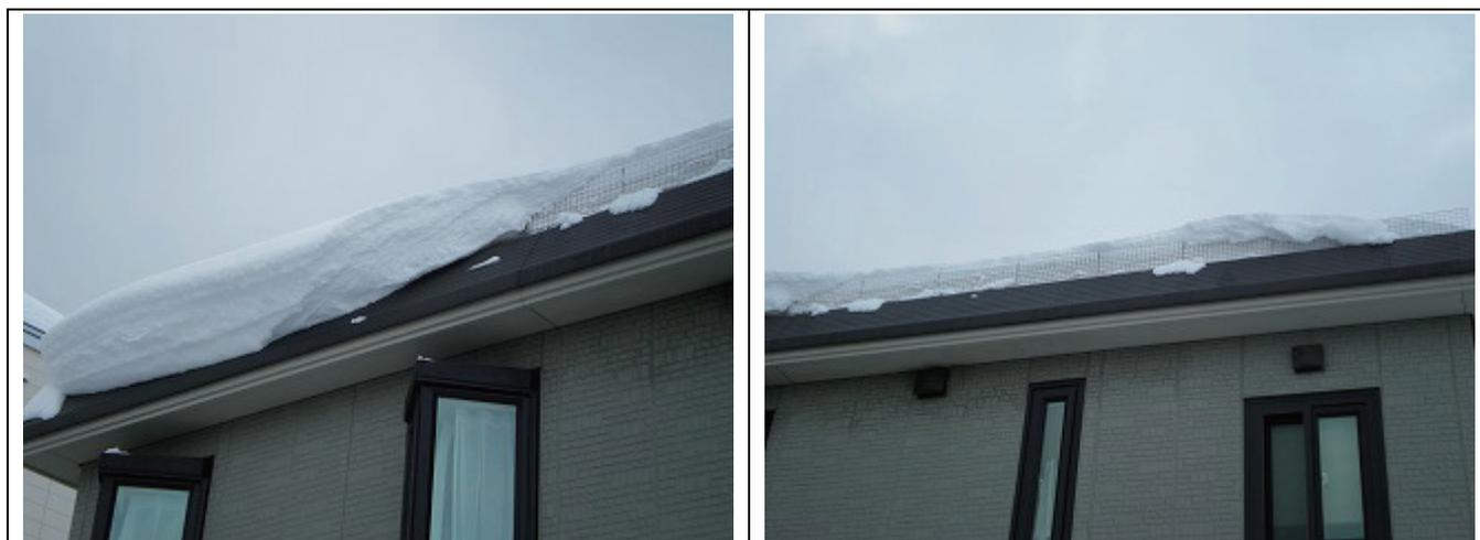
写真 6 屋根雪の雪庇状況 (2008年2月17日16:00頃)
