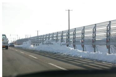
写真 13 有孔板を用いた吹き払い柵
