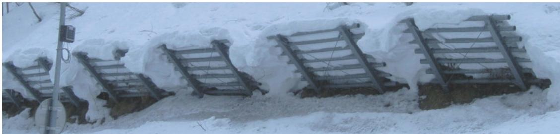
写真10 クリープによって柵と柵の間をはみ出した雪
