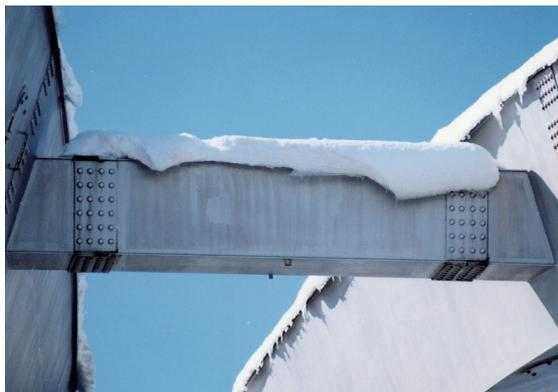
写真3 橋梁部材から破断した雪庇
