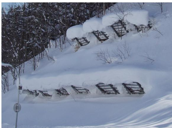
写真5 上段と下段で異なる形状の雪庇
