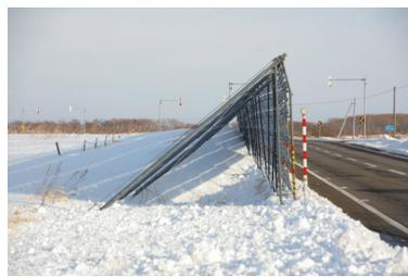
写真 10 下部間隙の閉塞した事例
