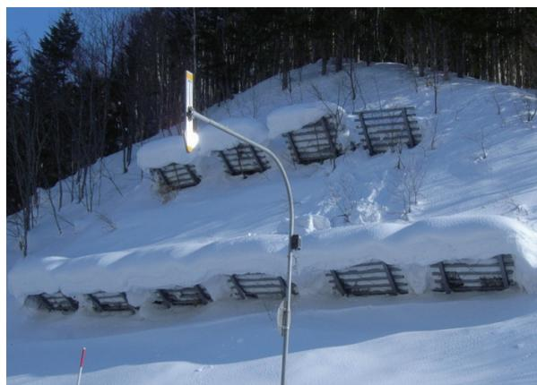
写真6 上段の柵からの雪庇崩落
