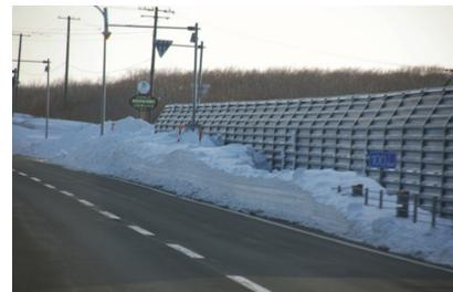
写真 8 防雪柵設置箇所での吹きだまり事例
