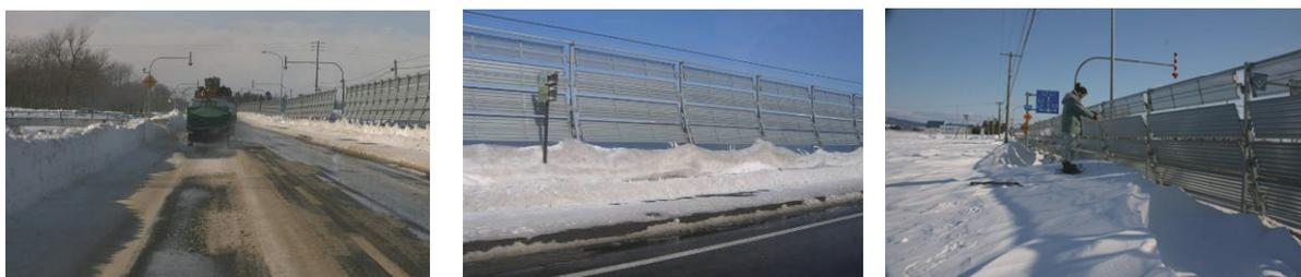
図 7 吹き払い柵(上部有孔板タイプ)の設置された区間の吹きだまり状況 (KP33.5-34.4 付近)
