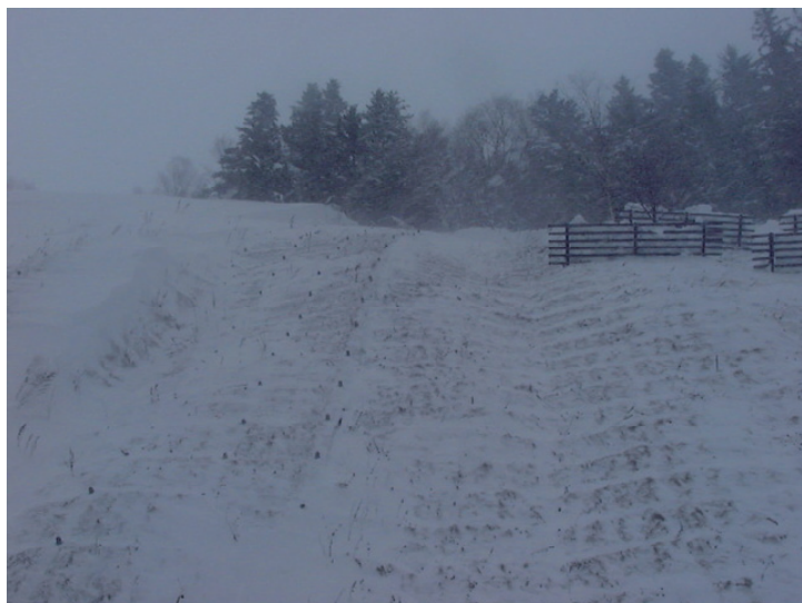
写真-3: 雪崩発生直後の、のり面と雪崩発生点
