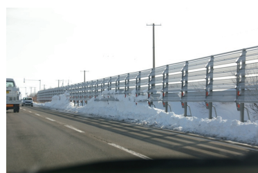
写真 13 有孔板を用いた吹き払い柵 (R44 浜中町 熊牛)
