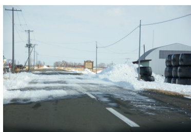
写真2 道路の吹きだまり状況 (町道 別海町 虹別付近)
