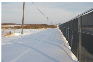
写真 9 柵風上への堆雪の少ない事例 (浜中町内)
