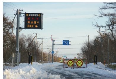
写真 6 通行止めの状況 (厚床付近)
