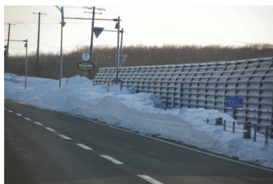
写真 8 防雪柵設置箇所での吹きだまり事例 (根室市 湖南)
