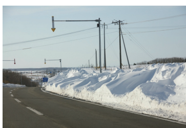
写真 12 短い切土の吹きだまり (R44 浜中町 姉別)
