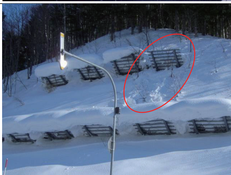
写真1 雪崩予防柵の問題点を示す状況写真（上段：雪崩のすり抜け防止用に張られた金網，中段：最下段の柵の下から発生した全層雪崩，下段：柵に形成された巻き垂れ）
