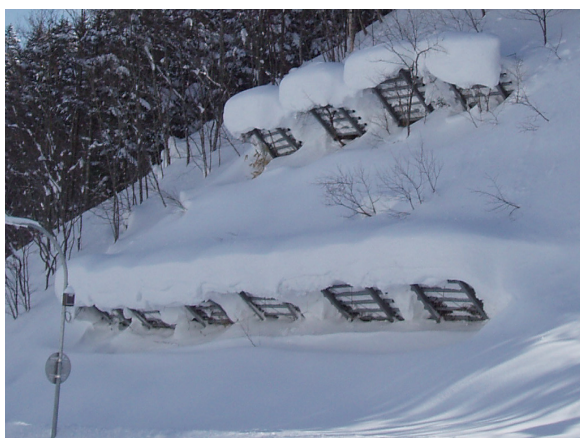
写真5 上段と下段で異なる形状の雪庇
