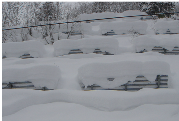
写真2 柵が積雪深より著しく大きい
