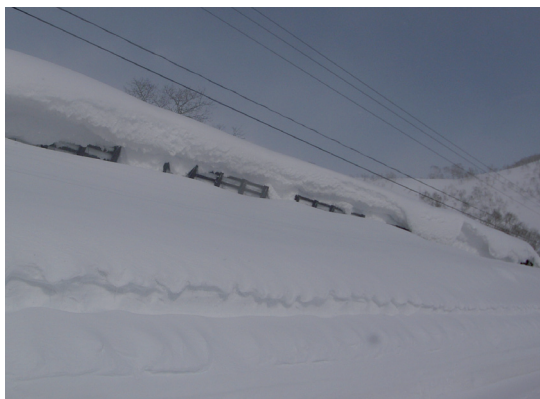
写真1 積雪深と雪崩柵の差が小さい
