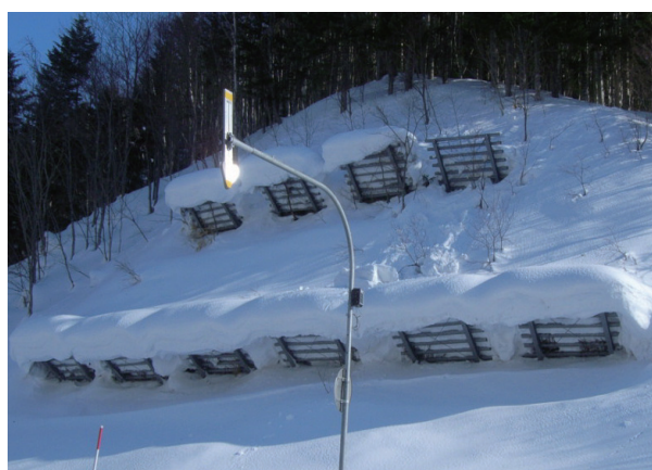
写真6 上段の柵からの雪庇崩落
