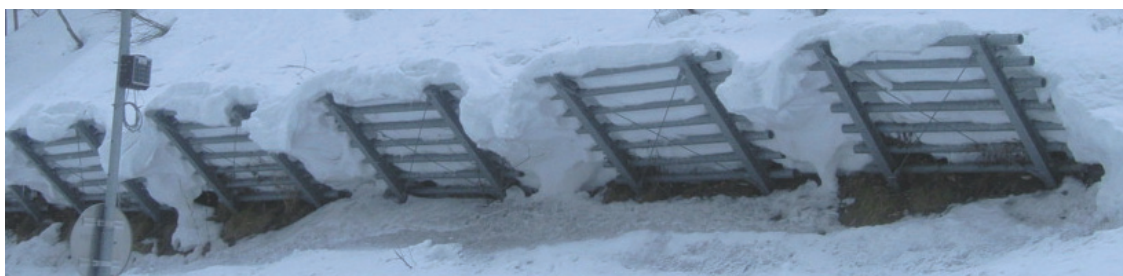
写真 10 クリープによって柵と柵の間をはみ出した雪
