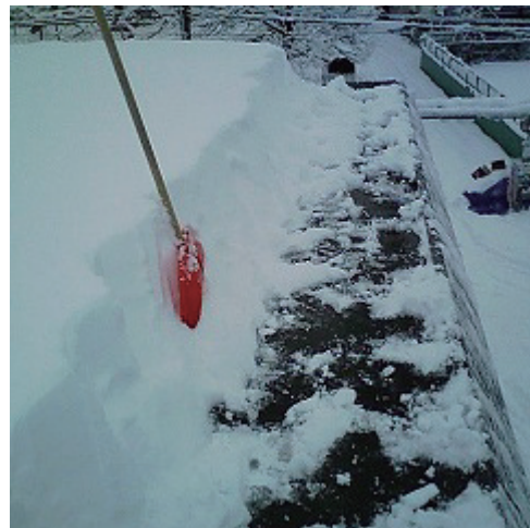
写真 2 屋根の底部分の雪庇除去
