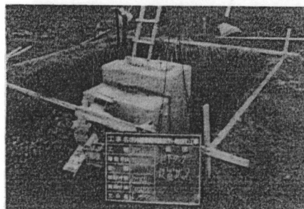
写真-9 地下タンク設置
