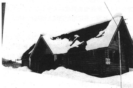
写真1 屋根雪の部分落雪
