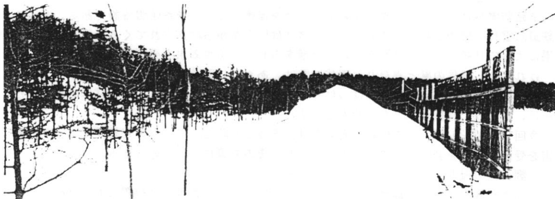
写真-2 防雪柵の風下側に大雪丘が形成され、樹木は埋没していた(右手が風上側)
