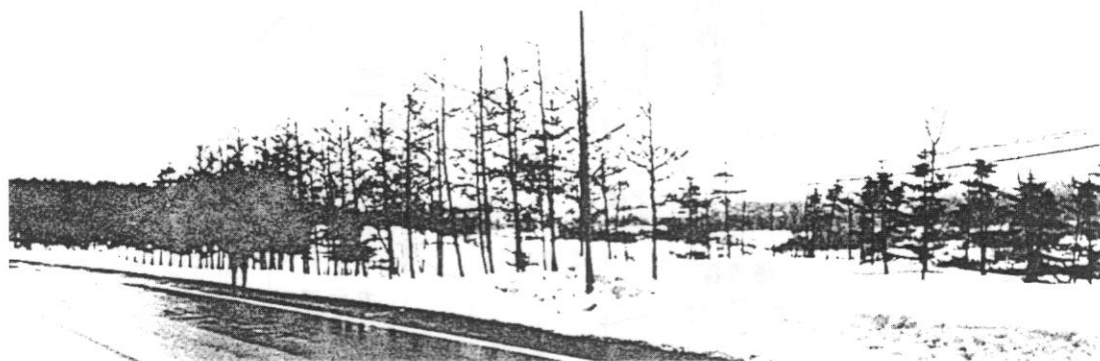
写真-1 国道243号線の道路防雪林: 道路沿いの樹木だけが生残った(1994.3.9)
